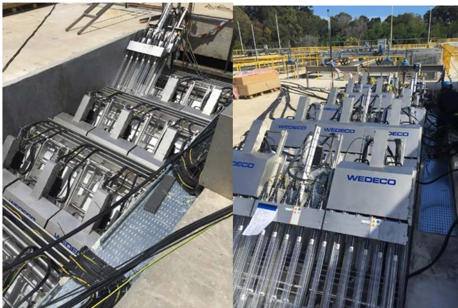
Figura 9 Instalação do Duron na planta ETE Punta del Este
